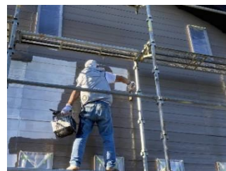
<外壁塗装>24日撮影
