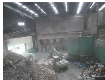
<雑廃材処分>リサイクルに。25 日撮影
